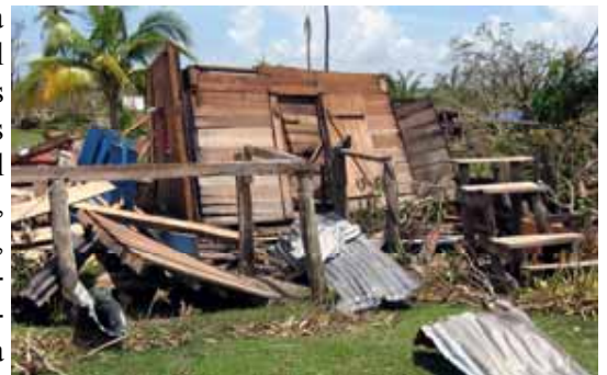
CAMINANDO SIN RUMBO. Felix generó lluvias torrenciales y grandes vientos que destruyeron miles de los hogares de gente pobre..
